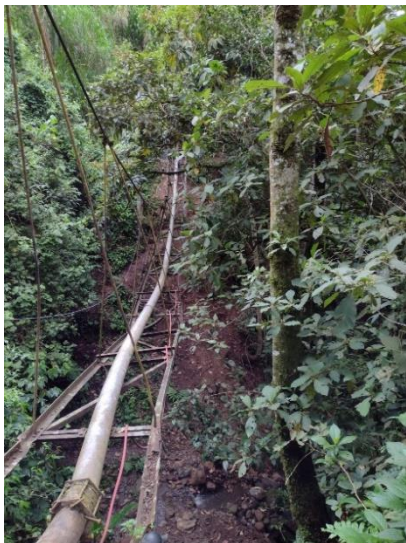
Paso elevado antes del proyecto
