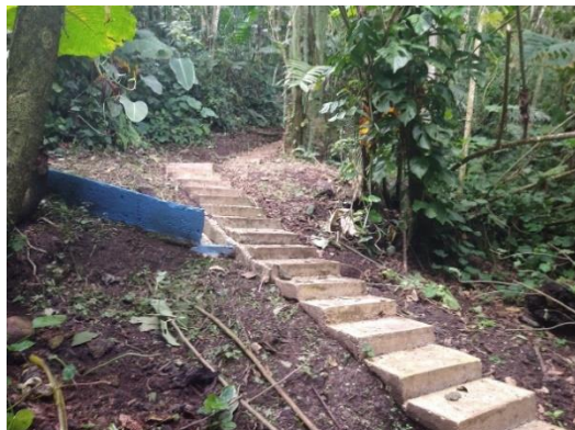
Gradas de acceso para mantenimiento
