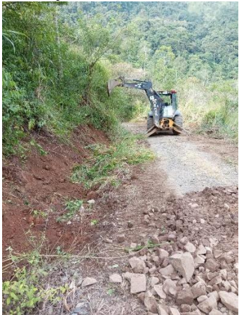
□ Limpieza mecanizada de drenajes, sector San Martín de Pejibaye
