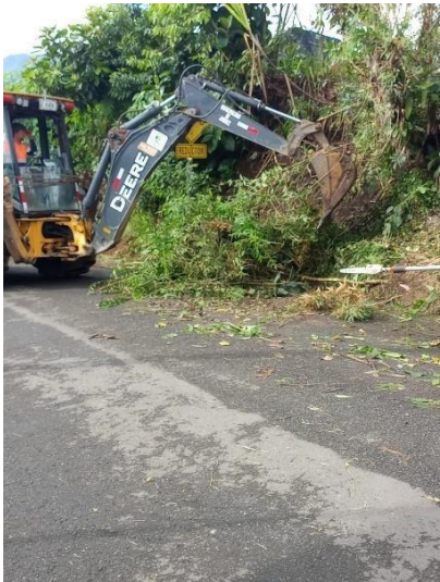
□ Limpieza mecanizada de drenajes, sector Bajos El Humo
