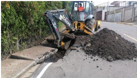
6. Sustitución de un tramo de alcantarilla obstruida por basura en el sector de Buenos Aires, frente al Supermercado Palí.
